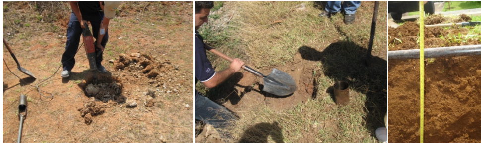
Figura 3.1 Remoción de sección de 50 cm de material superficial
